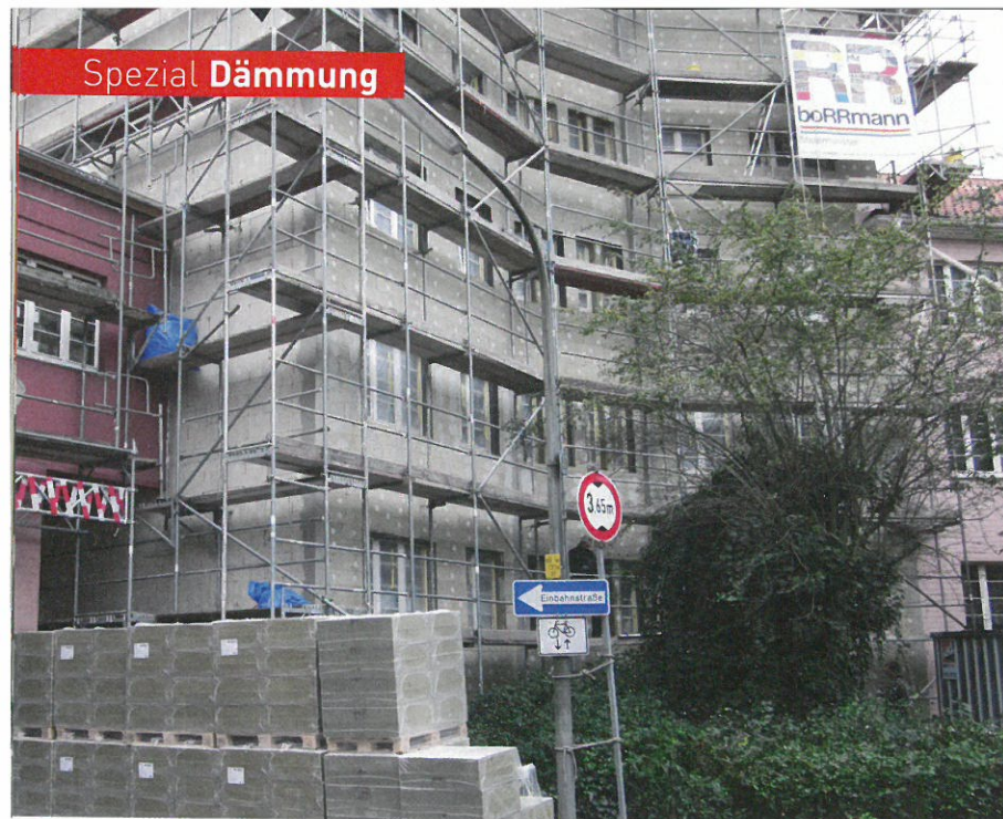
Zur Ausführung kam ein mineralisches WDV-System mit reduzierter Dämmstoffdicke
