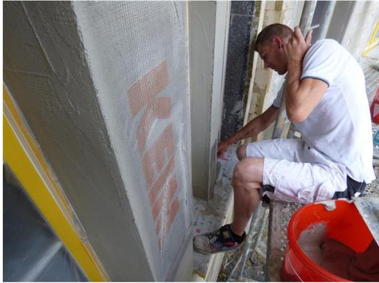
Im Anschluss wurden die Flächen in einer Schichtdicke von ca. 4 mm mit einem mineralischen Armierungsmörtel armiert. Verwendet wurde eine Glasfaser-Gittermatte mit einer Maschenweite von 4 mm × 4 mm.
