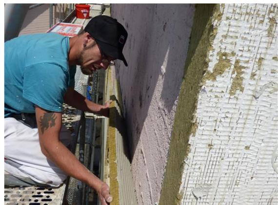
Der historische Bestandputz wurde als tragfähiger Untergrund weitestgehend erhalten, die Wülste der Kammzugtechnik behinderten die erforderliche Dämmplattenverklebung
