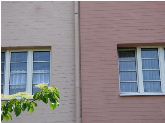
Das klassische „Schießscharten“-Thema konnte nicht zuletzt durch die Wahl einer Dämmstärke mit Augenmaß verhindert werden. Dies soll kein grundsätzlicher Appell gegen stetig steigende Dämmstoffdicken im Bereich energetischer Sanierungen sein. Doch gerade bei der Sanierung von Bestandsgebäuden sollte nicht zwangsläufig die maximale Dämmstoffdicke ausgeführt werden.
