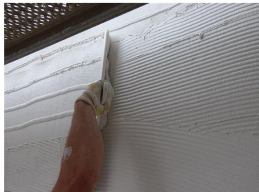
Die zweifache Beschichtung erfolgte mit einer Farbe auf Sol-Silikatbasis KEIM Soldalit, die ausschließlich mit lichtechten anorganischen Pigmenten hergestellt wird. KEIM garantiert für seine "Klassiker" in der Fassadenbeschichtung eine 20-jährige Farbtonkonstanz an der Fassade für pigmentbedingte Farbtonveränderungen. Eine Sicherheit, die der Bauherr in der Planung und Gestaltung erwarten darf.
